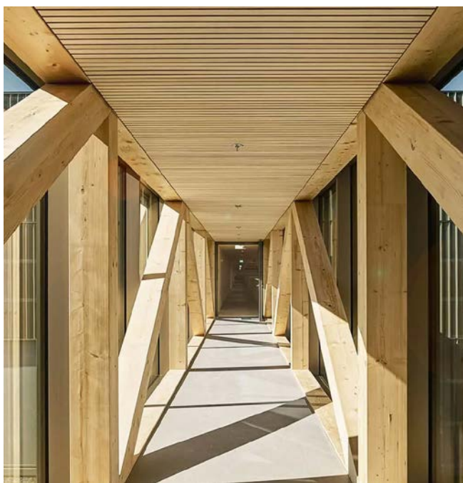
Foto: HK Architekten/Schlösser Ingenieurbau
